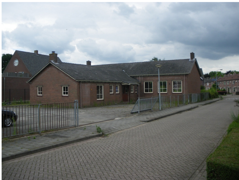
Foto 8 Achteraanzicht en terrein aan achterzijde
