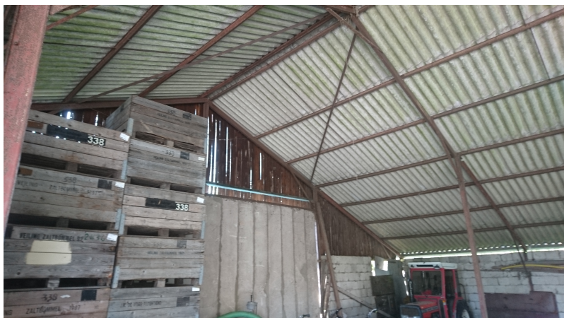
Te verwijderen open kapschuur in het plangebied, geen mogelijkheden voor vleermuizen, mussen of uilen. Foto: F. V. van der Lans | Ecoresult B.V.
