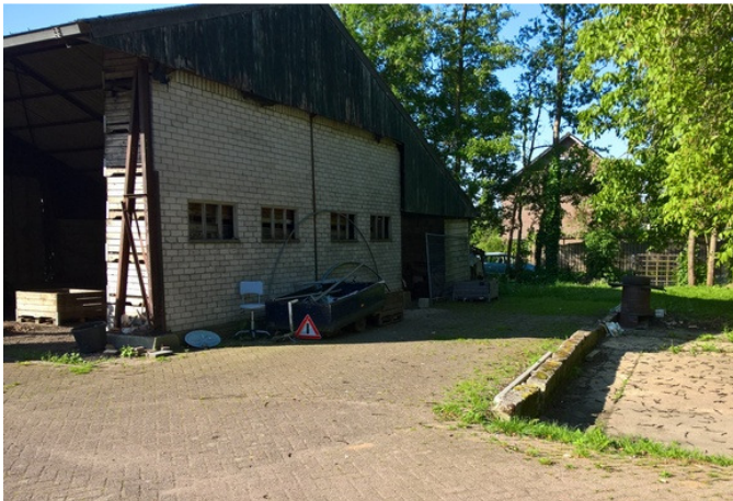
Foto 3: westzijde locatie / landbouwschuur
