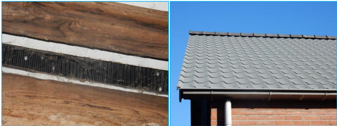
Foto's: Vogelwering dak en dakpanplaat.
