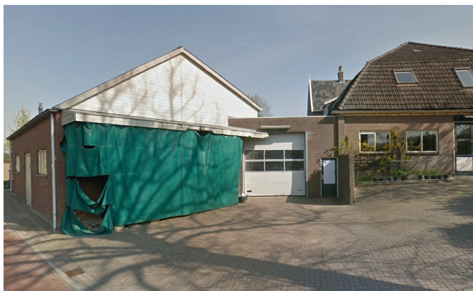
Foto 4: voormalige werkplaats / middengedeelte locatie (vanaf zuidoostzijde)
