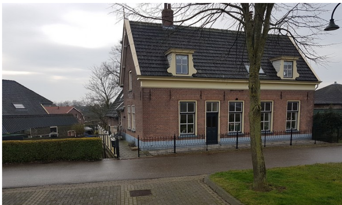
Foto 1: woonhuis / noordoostelijk gedeelte locatie (vanaf noordzijde)
