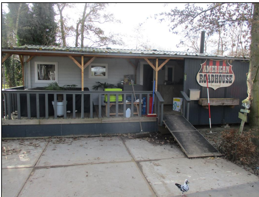
Figuur 2 De stacaravan met overkapping (B) op de planlocatie.
