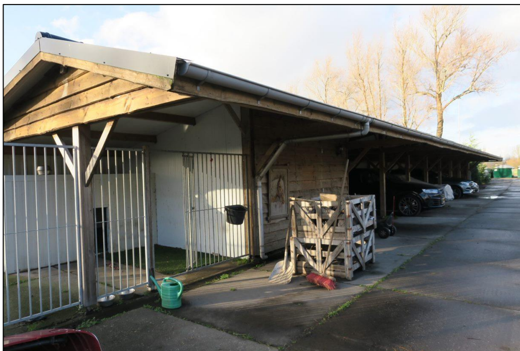
Figuur 1 De overkapping welke (mogelijk) gesaneerd zal worden.
