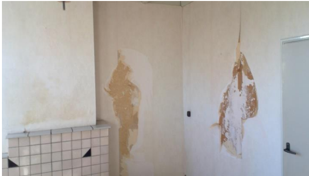
Foto 22 | Foto voor bron Wandbeplating
