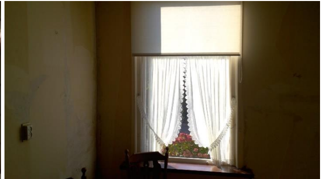
Foto 14 | Foto voor bron Beglazingskit
