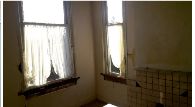
Foto 23 | Foto voor bron Wandbeplating
