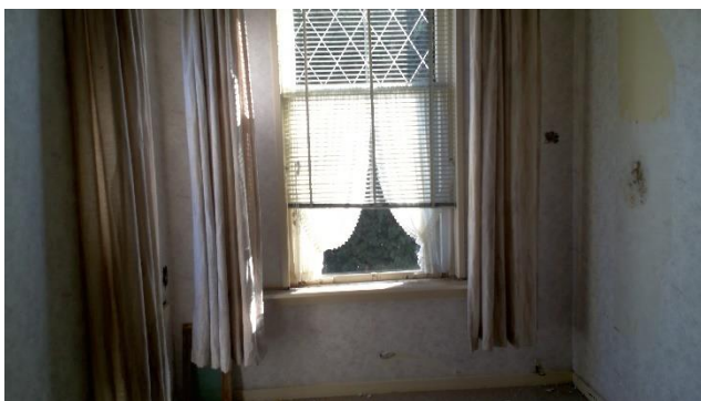
Foto 20 | Foto voor bron Wandbeplating
