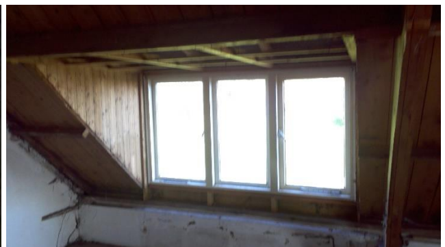
Foto 12 | Foto voor bron Beglazingskit
