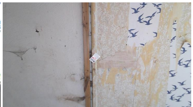
Foto 10 | Foto voor bron Wandbeplating
