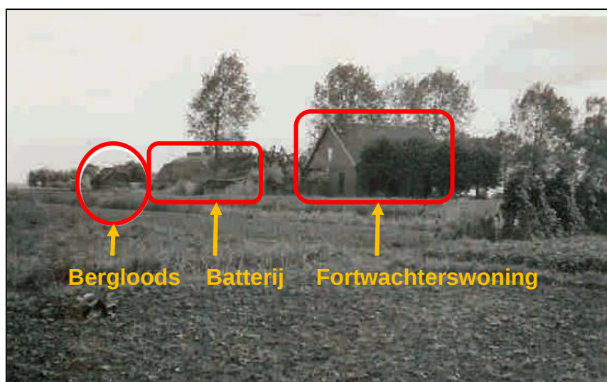
Weergave bergloods, batterij en fortwachterswoning
