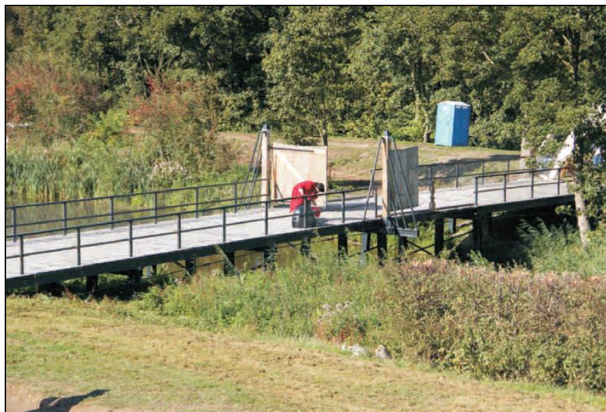
Gerestaureerde brug naar de batterij
