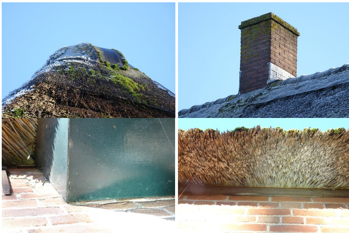
Afbeelding 17 t/m 20: Te verbouwen woning, zonder mogelijke vaste verblijfplaatsen van vleermuizen. Bron: BNL advies, datum: 21-12-2021
