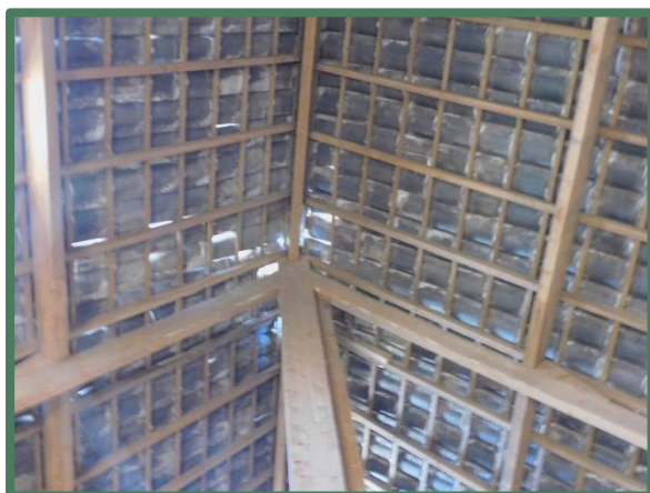
Onderzijde dak op de zolder
