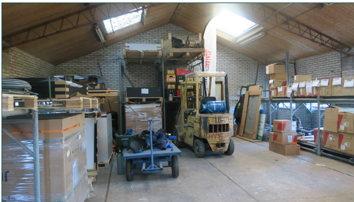
Figuur 7 Impressie van de binnenzijde van het westelijke deel van de schuur (1) wat is voorzien van dakbeschoot.
