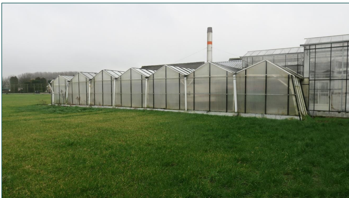
Figuur 2 Overzicht van de te slopen kas.
