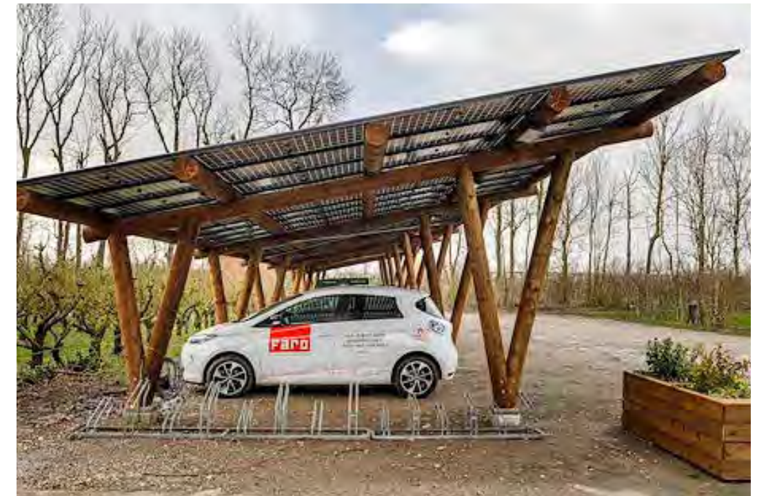
Referentie halfverhard parkeren - Zonnecarport Lisserbroek, FARO architecten
