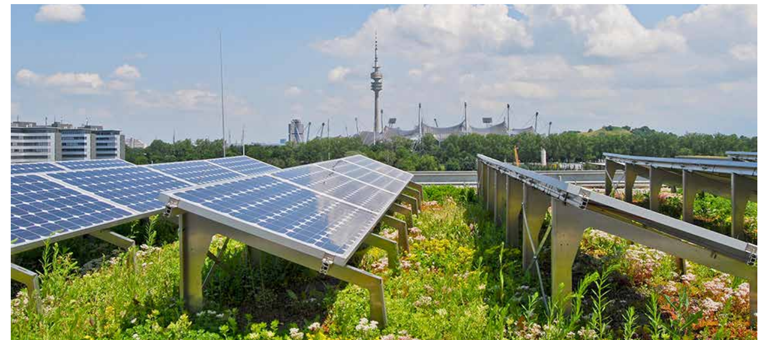
Referentie sedumdak met zonnepanelen - www.greenpro-online.be
