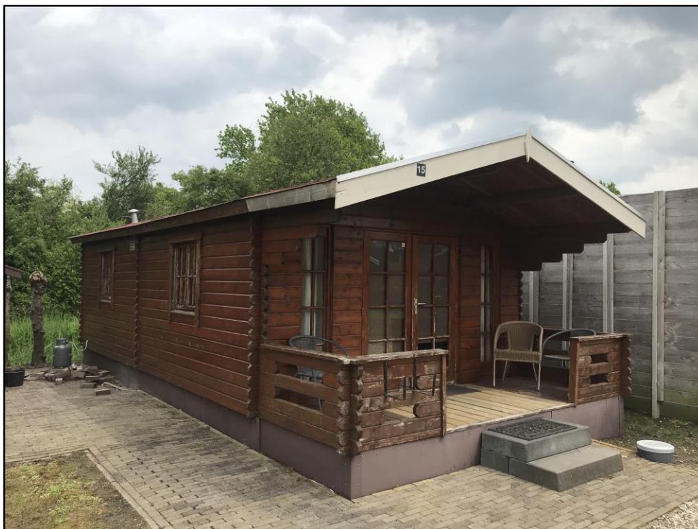
Figuur 2 De huidige recreatiewoningen op het campingterrein betreffen blokhutten en stacaravans.
