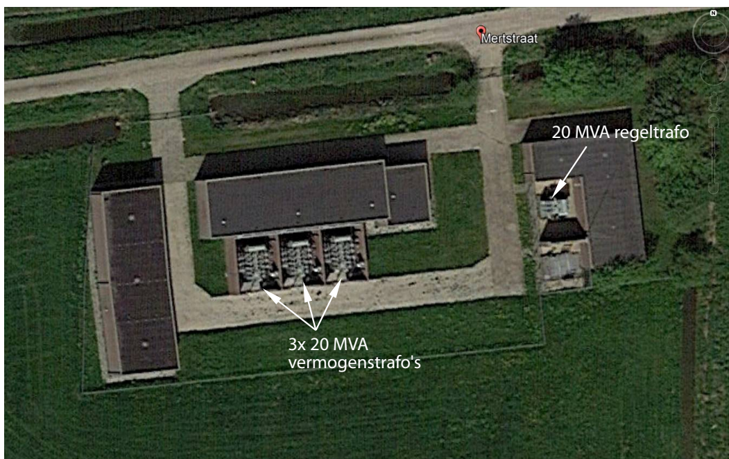
f2.1 Overzicht huidige regelstation Zuilichem
