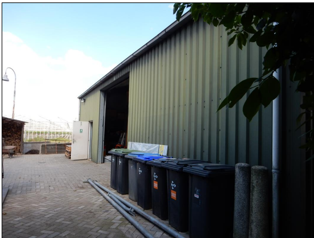
Figuur 2 Loods A op de planlocatie wordt gesaneerd.
