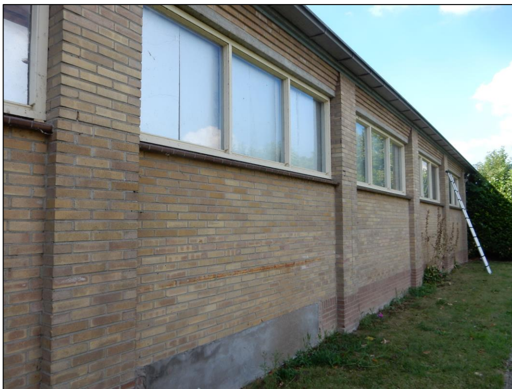
Figuur 3 Loods B op de planlocatie blijft behouden.
