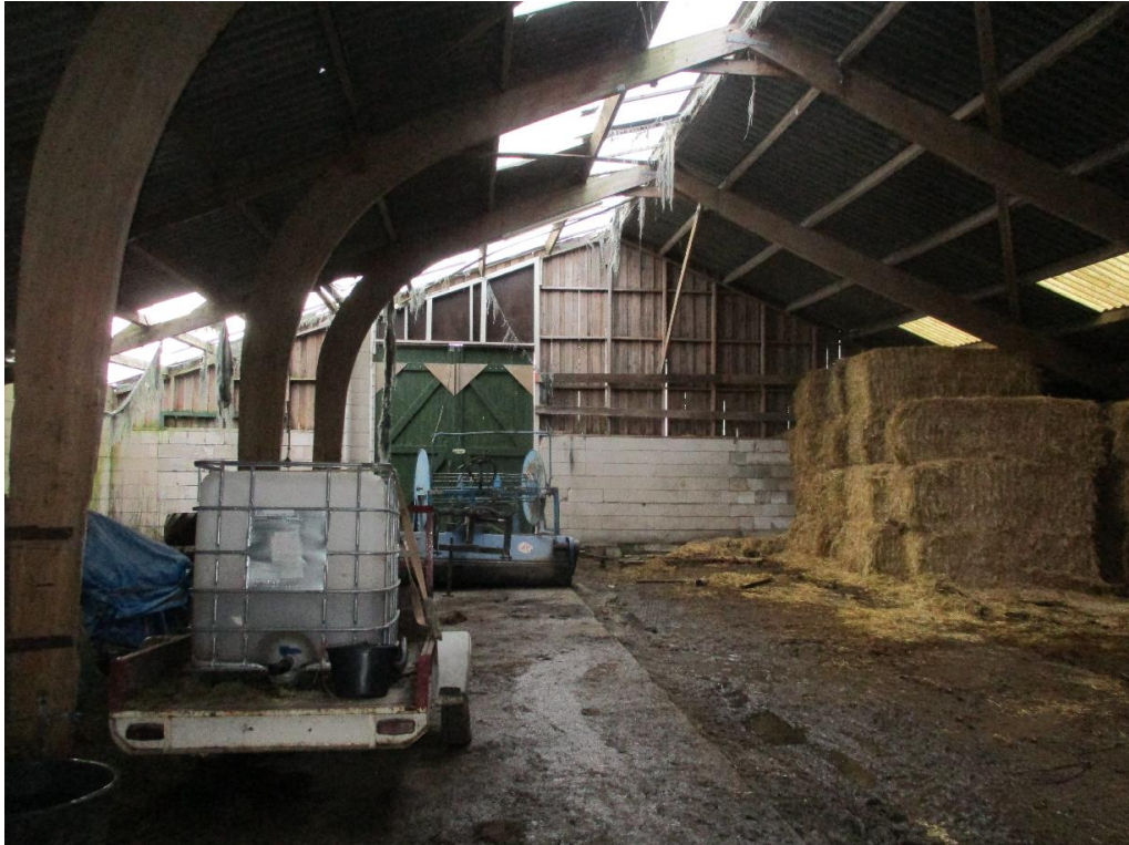
Figuur 4 De stal en schuur zijn opgetrokken uit betonnen muren met damwandenplaten en potdeksels.
