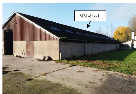
Foto 4: Geïntervieweerde schuur 1 met asbesthoudende golfplaat als dakbedekking vanuit oostelijke richting gezien.
