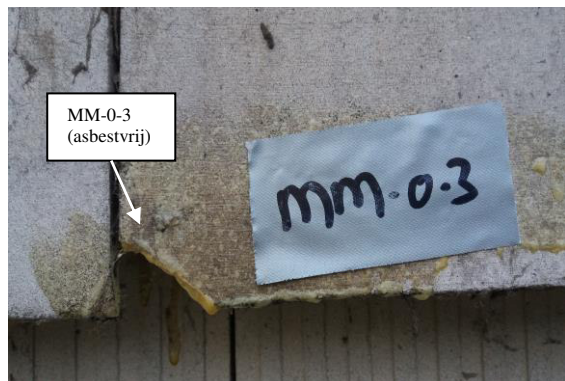
Foto 7: Asbestvrij plaatmateriaal als gevelafwerking van schuur 2.
