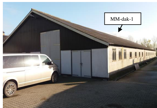
Foto 2: Geïntervieweerde schuur 1 met asbesthoudende golfplaat als dakbedekking vanuit noordwestelijke richting gezien.
