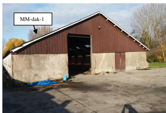
Foto 3: Geïntervieweerde schuur 1 met asbesthoudende golfplaat als dakbedekking vanuit zuidoostelijke richting gezien.
