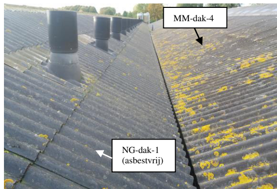
Foto 13: Asbesthoudende golfplaat als dakbedekking van schuur 2 en asbestvrije golfplaat als dakbedekking van schuur 3.
