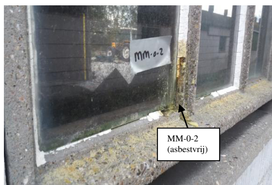
Foto 5: Asbestvrije stopverf in/aan de raamkozijnen van schuur 1.
