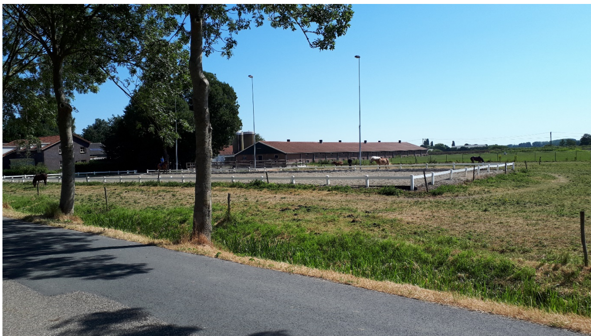
Figuur 3-4 Huidig aanzicht buitenrijbak vanaf wegzijde in noordoostelijke richting Bron: Google Streetview
