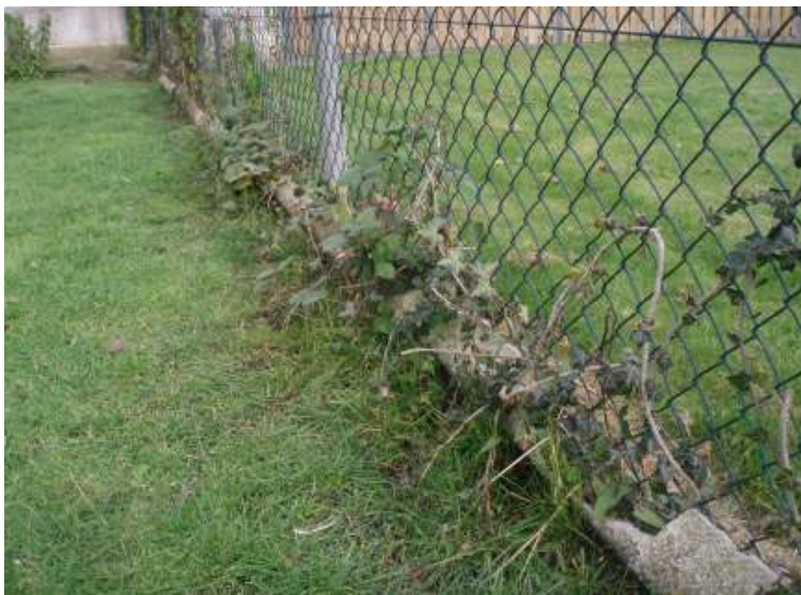
Keerwand achtertuin nr. 13
