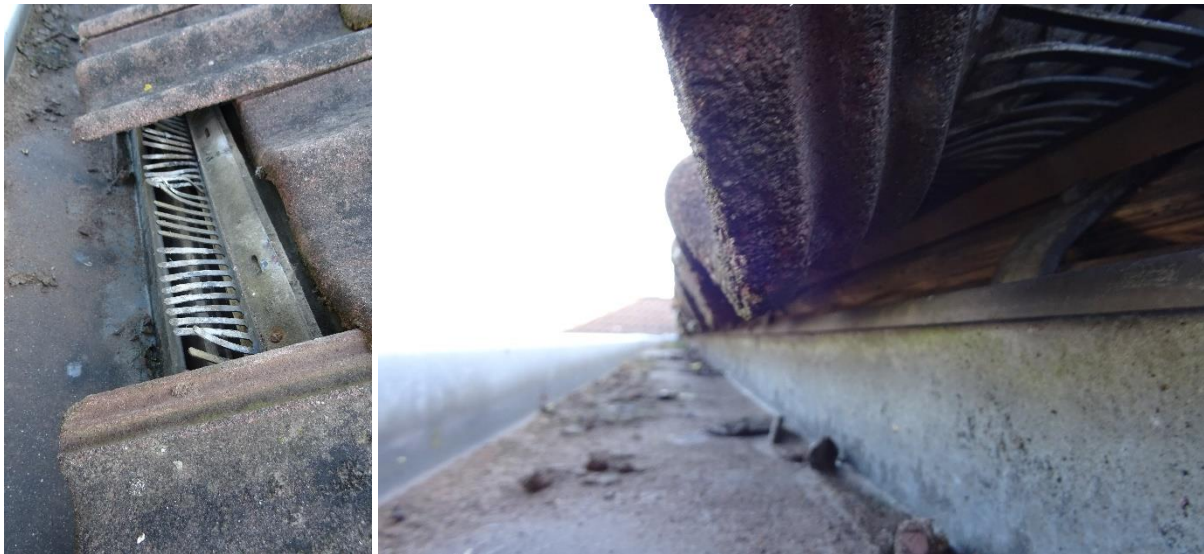
Afbeelding 2 en 3: Gezocht onder dakpannen naar nesten van huismussen, maar door het aanwezige vogelschroot is hier niets aangetroffen. Bron: Rik Bijvelds, 17-03-2020
