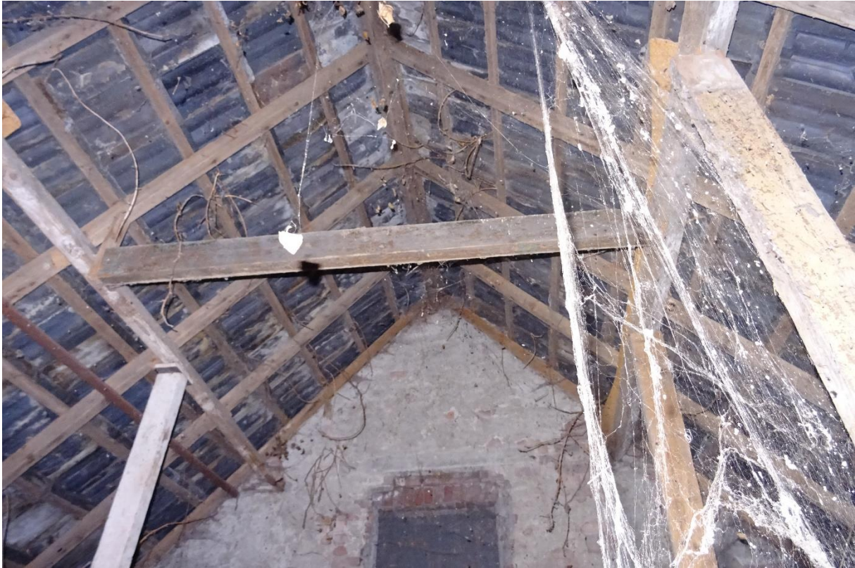
Afbeelding 4: Dakpannen in de schuur op panlatten zonder dakbeschoot . Bron: Rik Bijvelds, 17-03-2020
