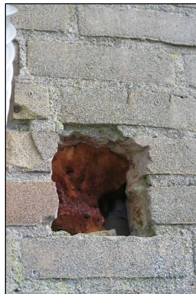
Foto 7. Opening in de muur aan de zuidkant van de kantine
