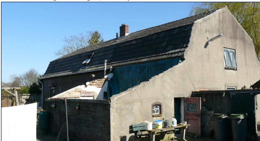
Bestaande woning Hoeveweg 18, achterzijde
