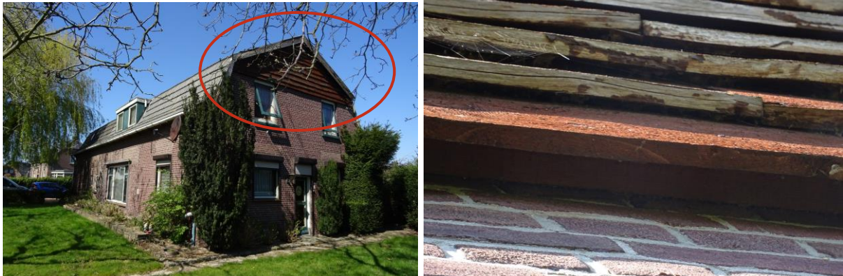
Afbeelding 11 en 12: gevelbekleding tegen woonhuis met openstaande planken waar vleermuizen gebruik van kunnen maken. Bron: Rik Bijvelds. Datum: 26-04-2021
