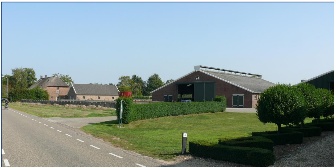
Stallen en sleufsilos bij Torenstraat 4
