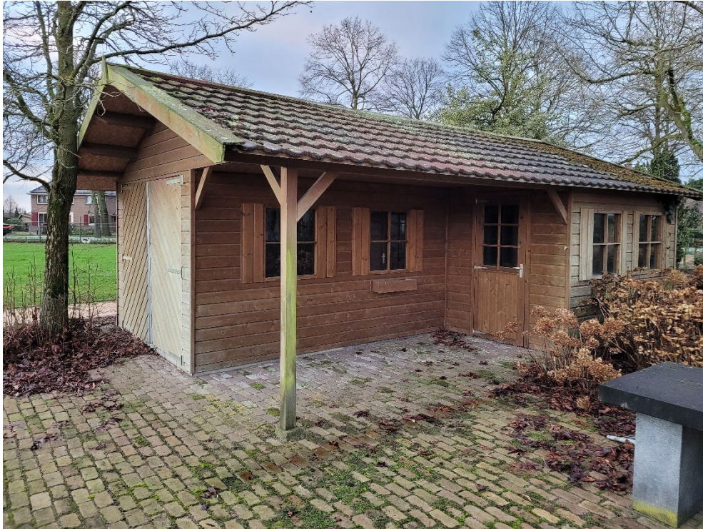
Figuur 2.4 Tuinhuis op verharde bestrating
