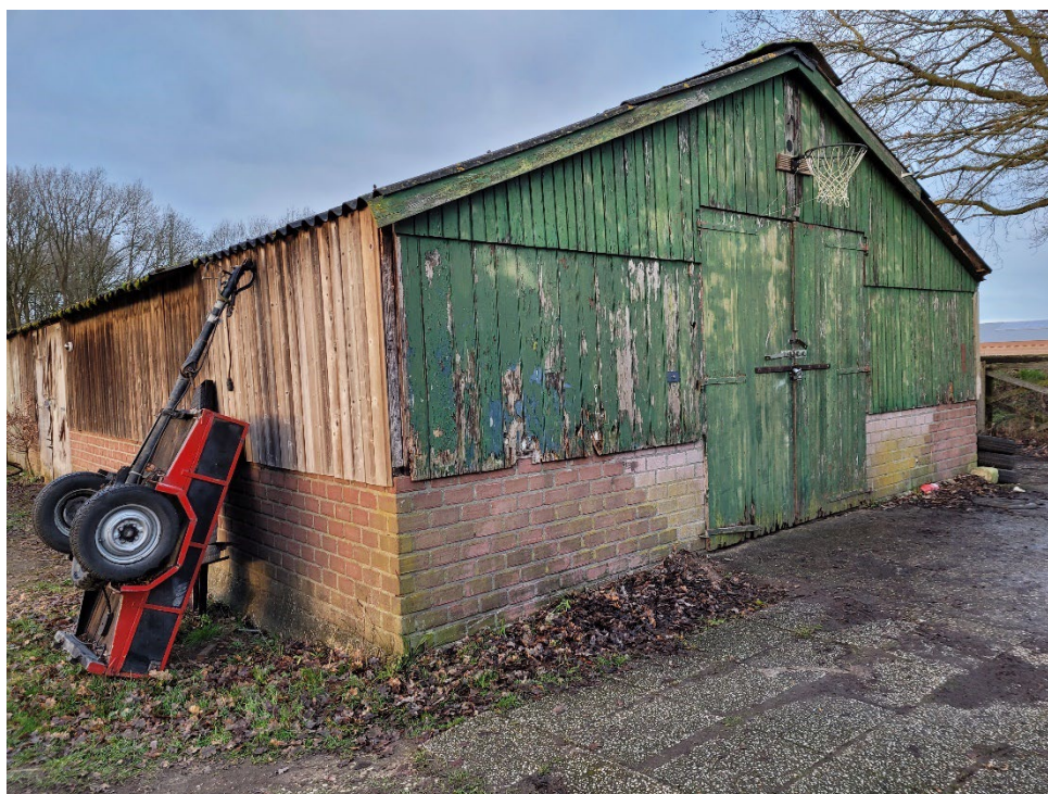
Figuur 2.7 De voormalige kippenschuur, die nu in gebruik is als opslagruimte voor particulieren
