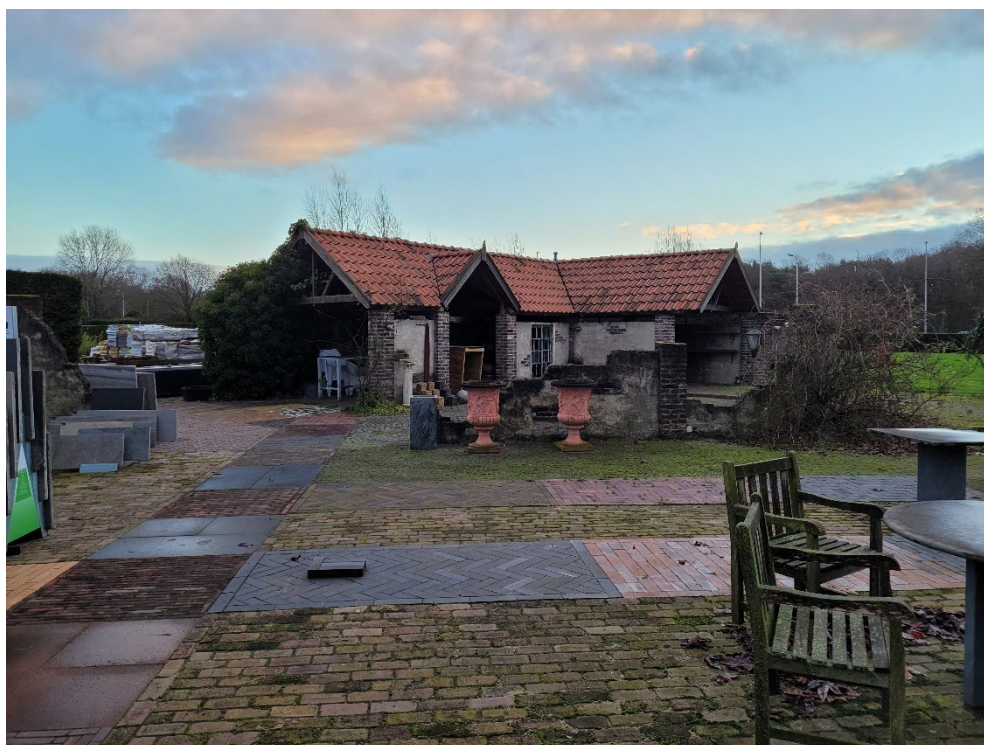
Figuur 2.3 Overkapping bestaande uit enkelvoudig metselwerk
