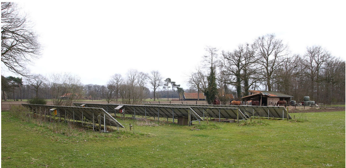
Foto 1. Zicht vanuit de noordwestelijke richting op het zonnepaneelveld aan de Sieverdinkweg in Kotten. De omvormers zijn achter/onder de panelen geplaatst. De grond tussen de onbeschermde panelen wordt door paarden begraasd.
