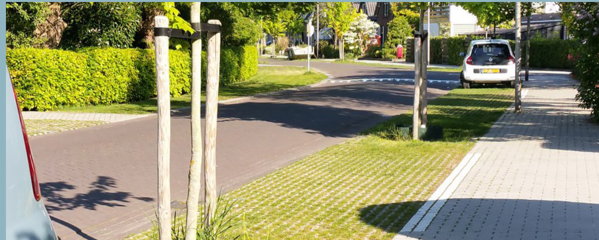
Voorbeeld van een straatprofiel met gebakken klinkers op de rijbaan en betonklinkers op trottoir
