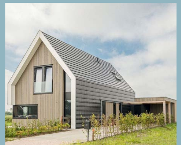
Elke woning is een architectonische eenheid.
