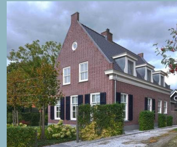
Roodbruine baksteen met landschappelijke detailleringen
