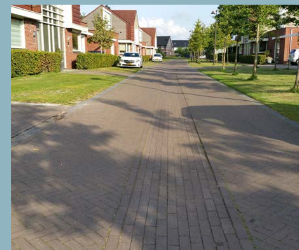
Kolkloze straten, water oppervlakkig afvoeren
