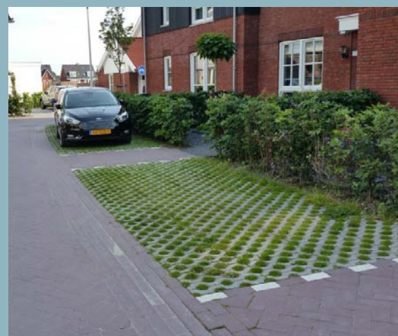
Parkeren op grasbetonsteen
