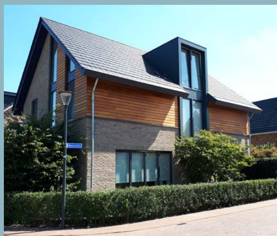
Gevels bestaan uit baksteen en/of hout, verfijnde detaillering
