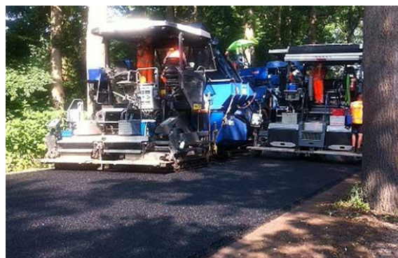
Aanleg stil asfalt N319
