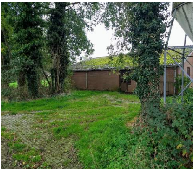
Fig. 8 - Bestaande toegang tot locatie nieuwbouw vanaf Guldenweg
