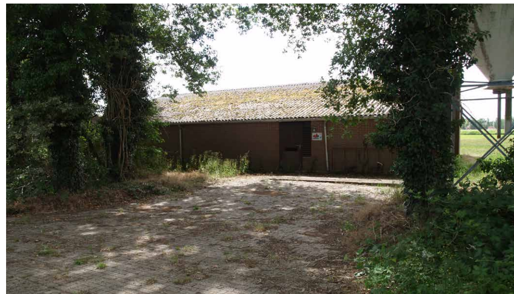
Foto: Te slopen varkensstal, aansluiting op de Guldenweg
