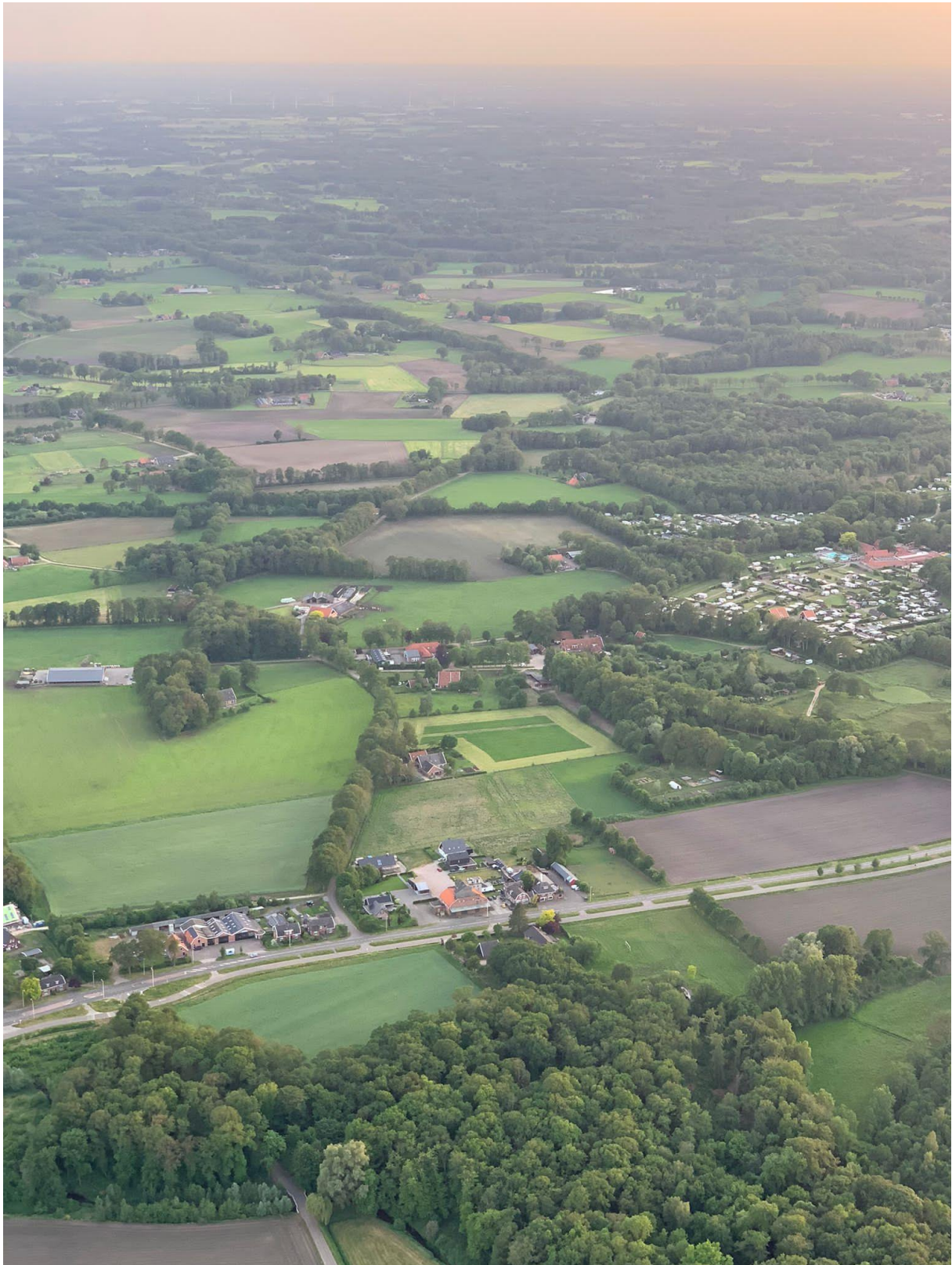
Overview Kottenseweg – Maalderij Locatie
