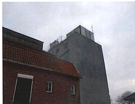
Foto 37: Stuc laag (Abm/101): geen asbest
