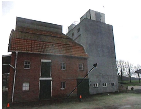
Foto 11: Stuc laag (Abm/101): geen asbest
