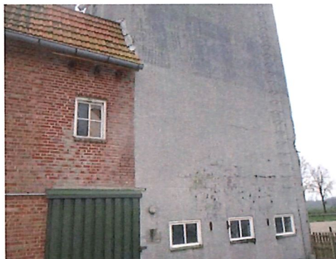
Foto 35: Stuc laag (Abm/101): geen asbest
