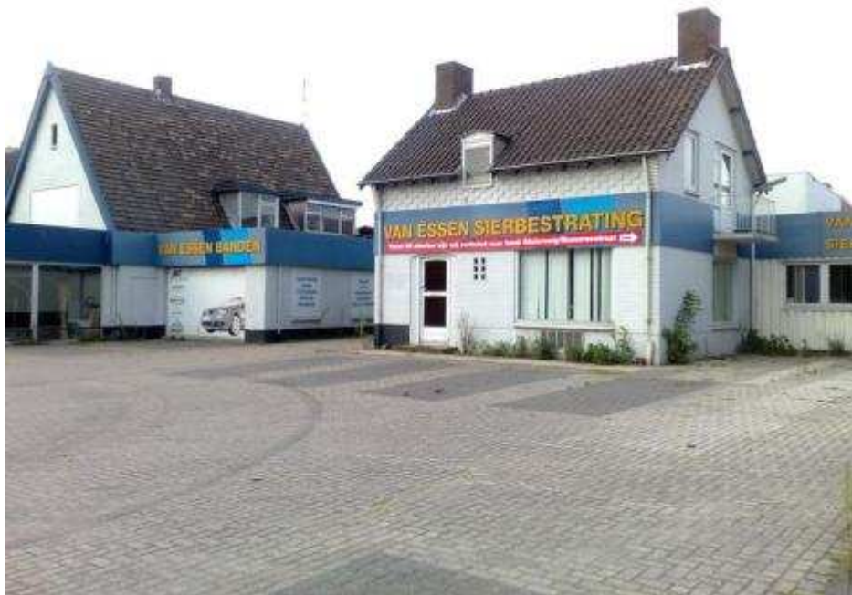
Afbeelding 2.1 foto van de voormalige bedrijfsbebouwing aan de Hamersestraat
