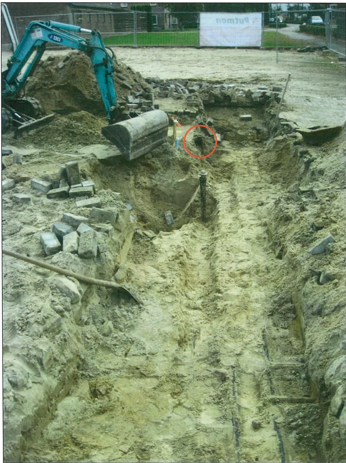
Foto 2: Ligging van de aangetroffen vulpunten (laatste vulpunt in rode cirkel), gezien vanaf boring 1003. Onder zichtbare vulpunten zijn de beide ondergrondse tanks gelegen. Aan onderzijde foto is de ligging van het leidingwerk duidelijk zichtbaar.
