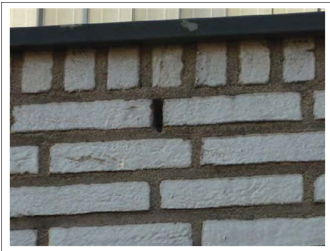
Foto 4. Open stootvoeg die aan gewone dwergvleermuis toegang tot spouw kan verlenen.
