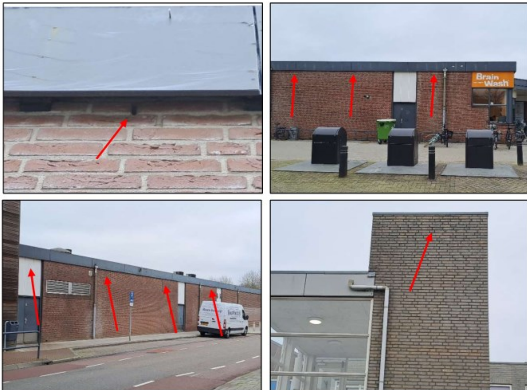
Afbeelding 7. Overzichtsfoto's van potentiële verblijfplaatsen voor gebouwbewonende vleermuissoorten (rode pijlen; van linksboven naar rechtsonder: a) open stootvoeg onder boeiplank aan zuidzijde van het complex, b) de zuidoostzijde van het complex, hier bevinden zich een aantal open stootvoegen, c) zuidzijde van het complex, hier bevinden zich een aantal open stootvoegen tussen de eerste en derde deur vanaf het westen geteld, d) open stootvoegen bij trappenhuis ten noorden van het plangebied) (foto's: Laneco, 2023).
