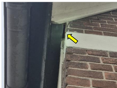
Figuur 4.34 Ruimte langs betimmering in de woning aan IJsseldijk 90 (gebouwcluster 4).
