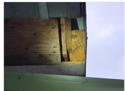
Figuur 4.36 Ruimte tussen betimmering onder het dak van de schuurwoning aan IJsseldijk 88 (gebouwcluster 7).
