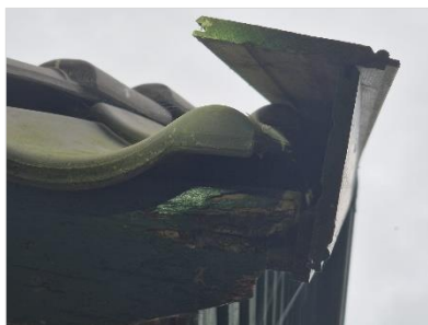
Figuur 4.9 Toegang tot dakruimte in schuurtje IJsseldijk 88 (gebouwcluster 6).
