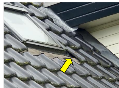
Figuur 4.11 Ruimte bij dakraam in woning IJsseldijk 90 (gebouwcluster 4).
