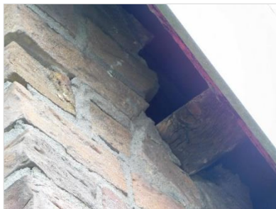
Figuur 4.32 Ruimte onder het dak van het entree gebouw (gebouwcluster 9).
