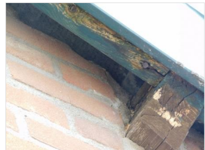
Figuur 4.33 Ruimte onder het dak van de schuur bij de akkers (gebouwcluster 10).
