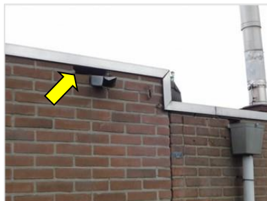
Figuur 4.4 Geschikte ruimte in de muur van de kleedkamers van de voetbalvereniging (gebouwcluster 9).
