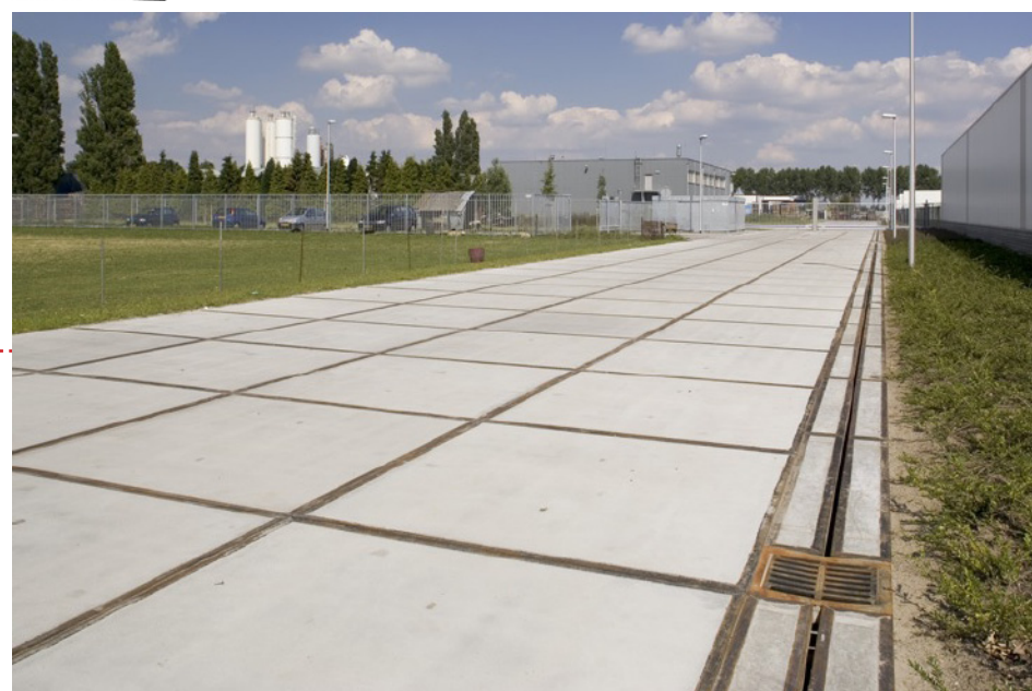
referentiebeeld plein stelconplaten 2x2m .
