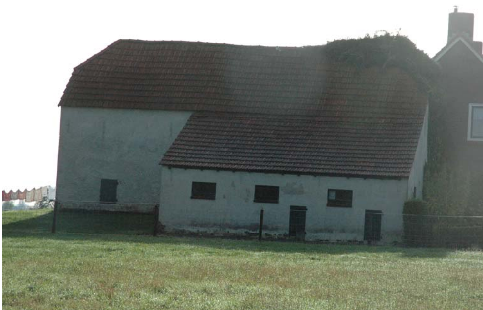
Afb. 25 Detail van de wit gepleisterde schuur. De laag geplaatste staldeurtjes geven aan dat het vermoedelijk een varkensstal was.
