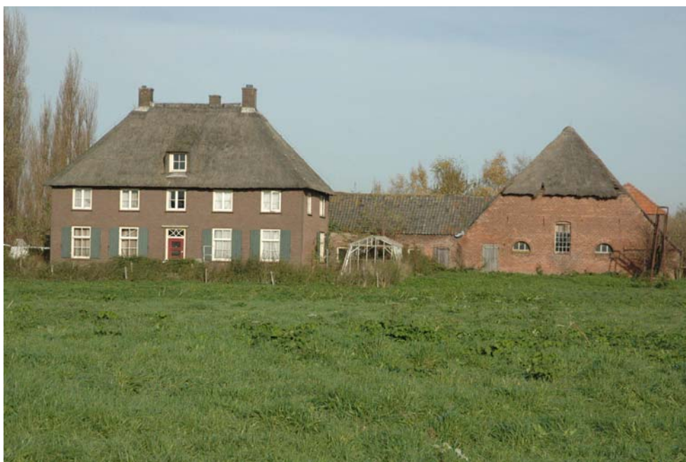
Afb. 17 De boerderij met bijschuur, gezien vanuit het zuidoosten. De voorgevel van de boerderij stamt uit de herbouwfase van 1948-49. De gevel van de schuur is vermoedelijk bij de vergroting van de schuur in de 19de eeuw gebouwd. De gevel van het tussenlid is van jongere datum.
