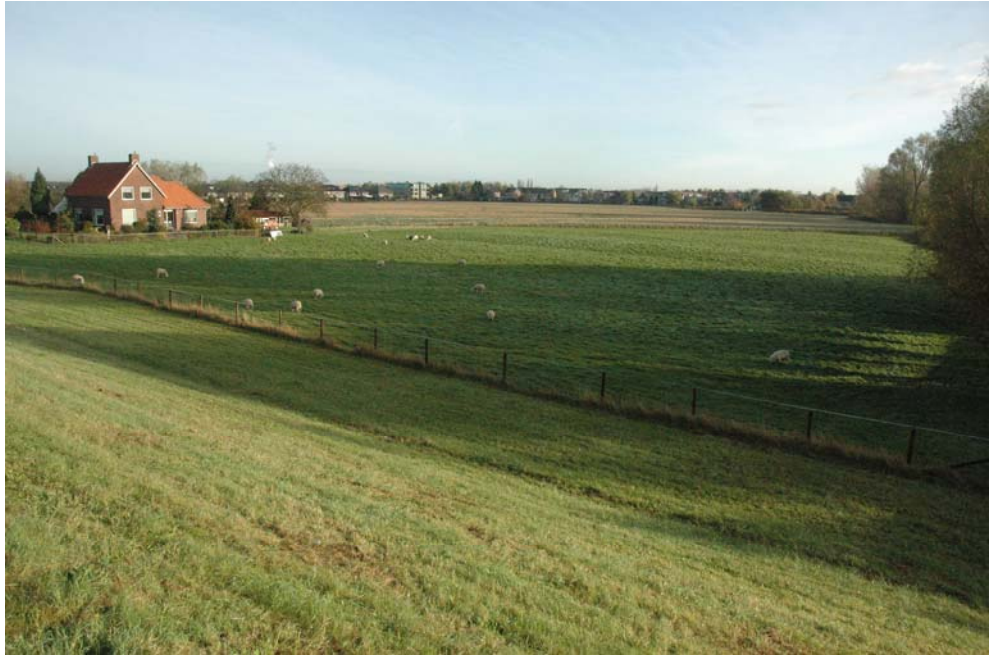
Afb. 2 Overzicht van het zuidelijke deel van het terrein. Hier bevond zich in de 18de eeuw het fort Geldersoord(h). Het pand links is Schans 7/7a. De resten van de nog aanwezige buitenste gracht bevinden zich ter plaatse van de bossages rechts op de foto.
