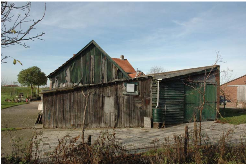
Afb. 6 Overzicht van de achterzijde van de schuuraanbouwen van het woonhuis.
