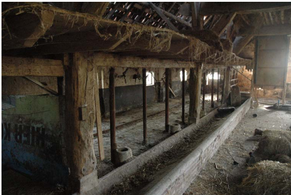
Afb. 18 Overzicht van het interieur van de bijschuur. De constructie zal uit de 19de eeuw stammen, de stalindeling is 20ste-eeuws.
