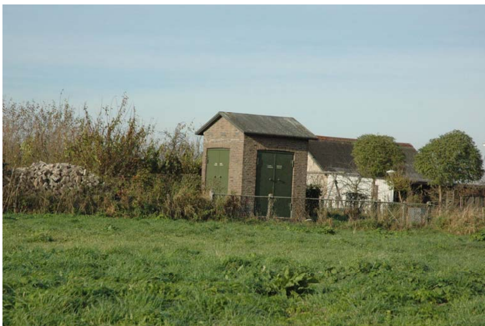
Afb. 23 Achter de moderne woning Schans 6 bevindt zich een elektriciteitshuisje. Gezien de geringe zeldzaamheidswaarde heeft het huisje een geringe cultuurhistorische waarde.
