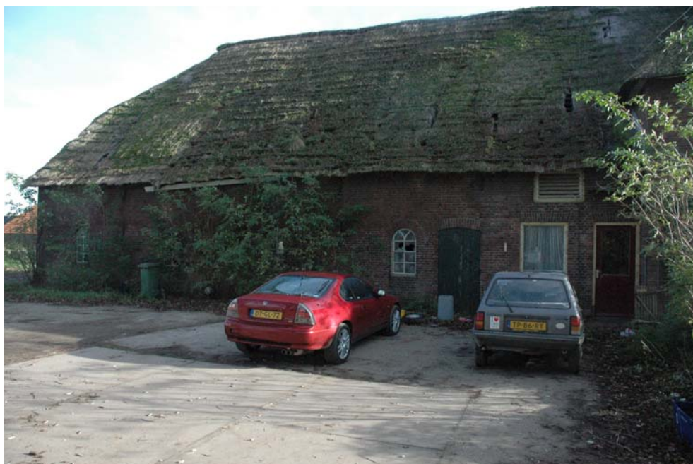
Afb. 14 De westgevel van boerderij Schans 4. Deze gevel zal grotendeels in de tweede helft van de 19de eeuw tot stand zijn gekomen.
