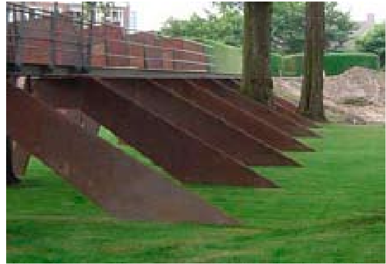
Referentie brug over inundatiekanaal
