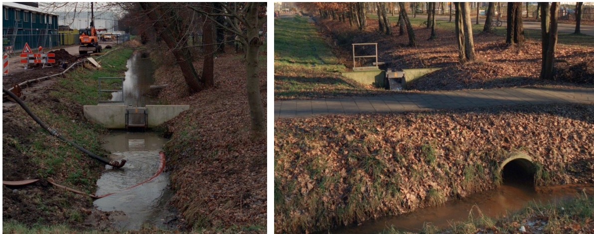
Figuur 5 Gerealiseerde stuwconstructies in de watergang langs de Plantage.
