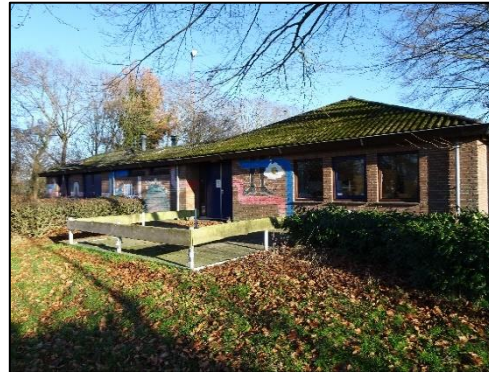
Aanzicht zuidzijde clubgebouw;
