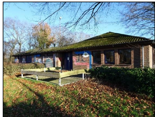
Aanzicht zuidzijde clubgebouw;
