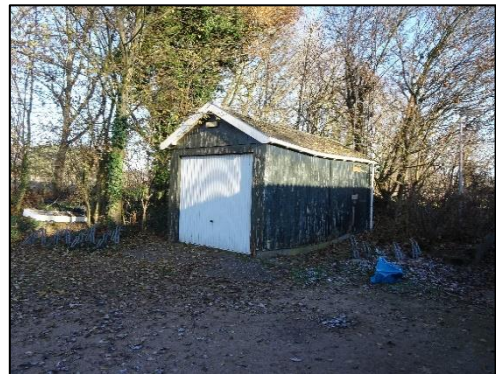
Aanzicht te slopen schuur;
