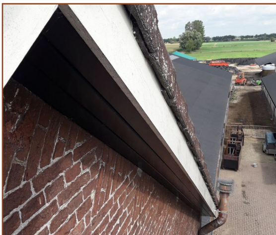
Afb. 2.6: De windveren sluiten naadloos aan op de gevel waardoor er geen openingen aanwezig zijn waardoor vleermuizen de spouw van de woning niet kan bereiken en gebruiken als vaste rust- en verblijfplaats.
