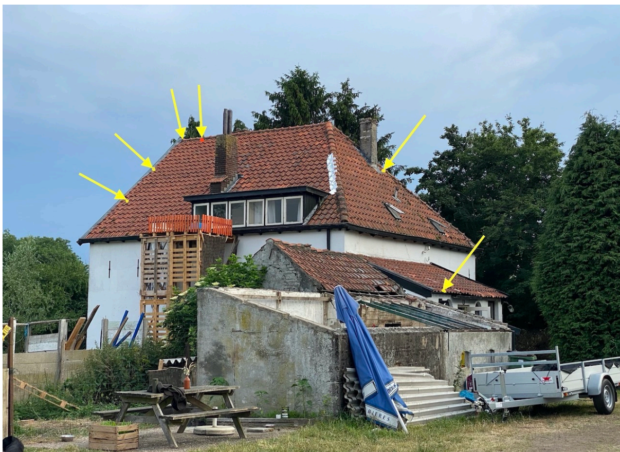
Foto 2 | Noord en oostzijde van het dak met indicatieve weergaven van de aangetroffen nesten. De pijlen markeren de plaats waar huismussen onder de dakpannen gaan, de nestplaatsen bevinden zich in de buurt van deze ingang onder de dakpannen. Op de achtergrond en rechts van de woning zijn de bomen en struiken zichtbaar die als slaap- en kwetterplaats gebruikt worden.
