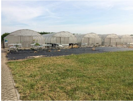
Foto 1 te verplaatsen tunnelkassen.
