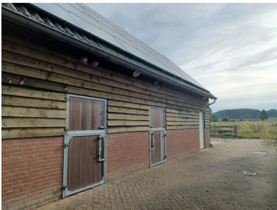
Foto 2. Detail betimmering en voorhangende dakgoot
