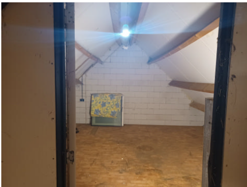
Foto 4. Zolder van de schuur.
