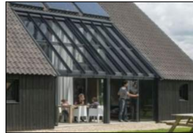
referentie glazen entree pui noordzijde
