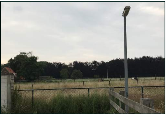
Hekwerken en verlichtingsarmaturen
